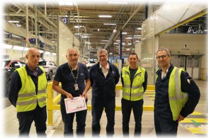
C. Houillon (Retouche/ éq A) : Mise en place d'une barrière permettant la retouche des véhicules en bord de ligne d'acceptation en toute sécurité. Gain : sécurité des retoucheurs et augmentation du nombre de retouches.
